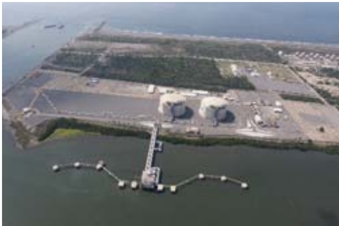
Manzanillo LNG Terminal
