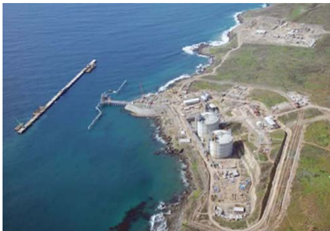
Energia Costa Azul Terminal
